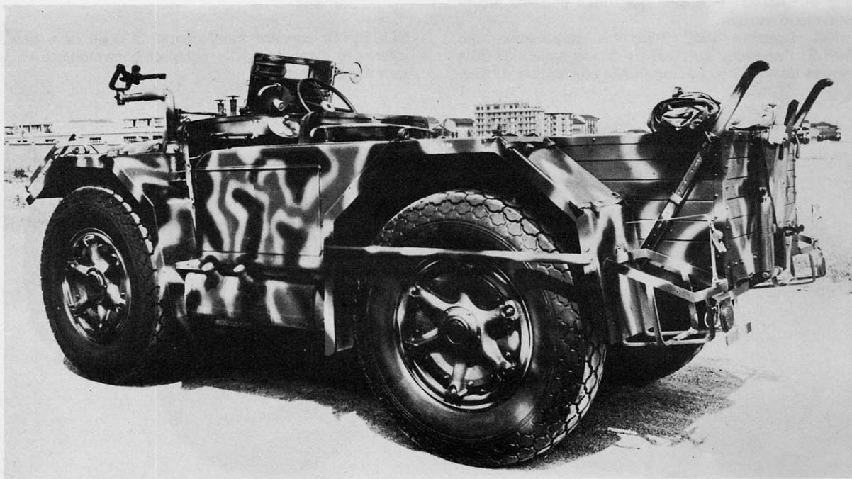
Vista di 3/4 posteriore sinistra dello stesso soggetto illustrato in copertina. Si possono osservare le molle del meccanismo di ribaltamento della ruota di scorta e parzialmente estratte le aste che servono a sostenere posteriormente il telone che si vede arrotolato. (Foto Viberti)
